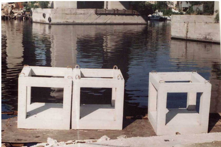
Фиг.1 Серия от три котви излети на площадка под Аспарухов мост.
